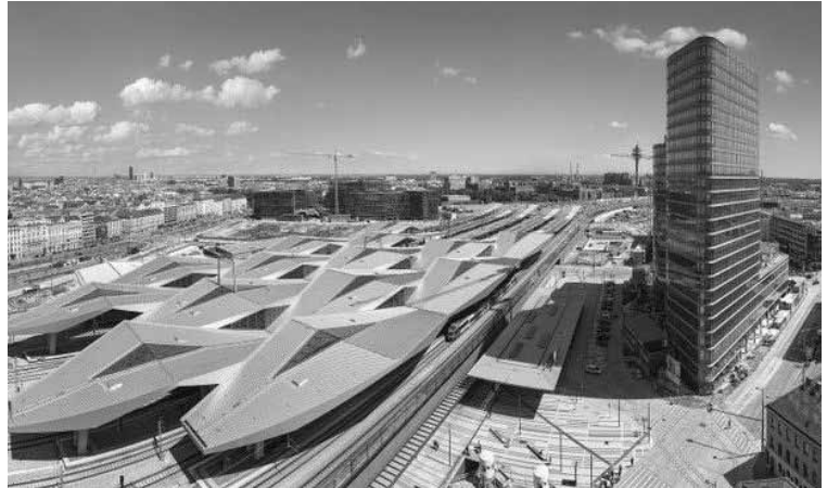
vielgerühmte Bahnsteig-Überdachung von oben
